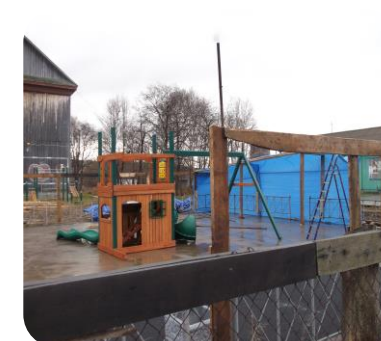
Устройство спортивной площадки в с. Хоэ
