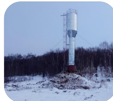
Установка водонапорной башни в с. Михайловка
