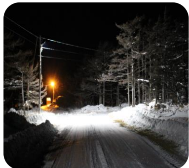
Капитальный ремонт уличного освещения с. Виахту
